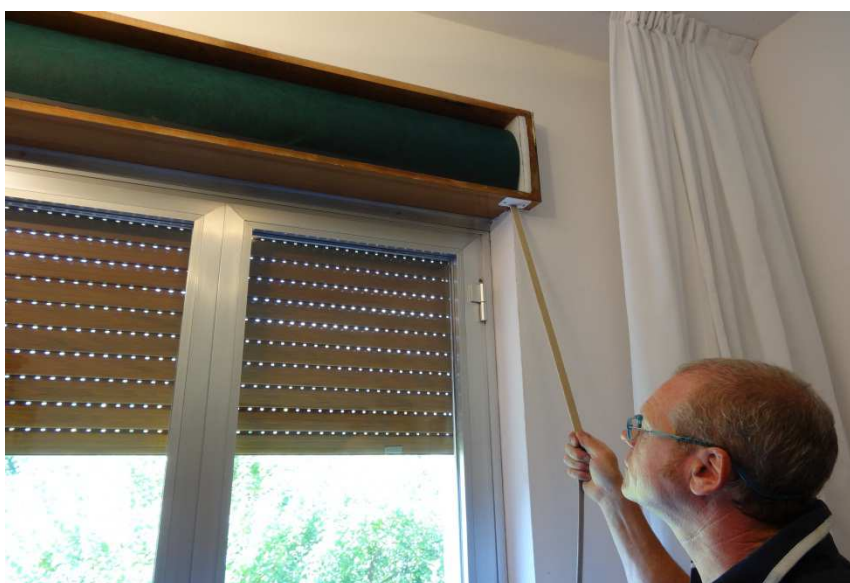
verifica del corretto funzionamento
