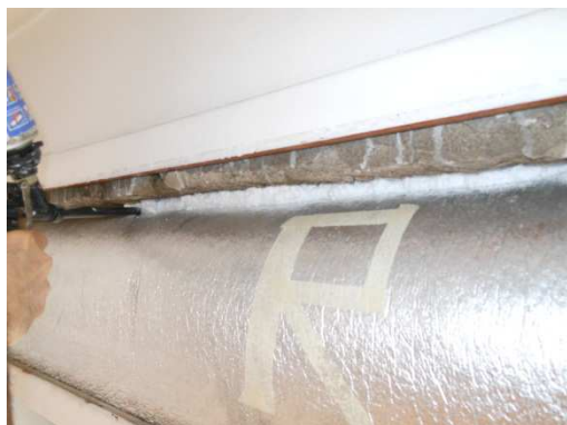
schiumare tutto il perimetro
