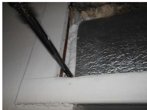
schiumare anche lungo i fianchi
