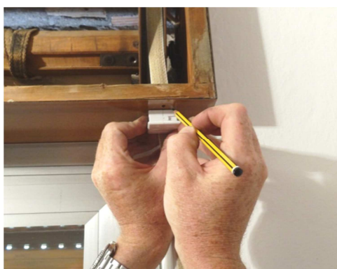
disegnare la sede del guidacinghia
