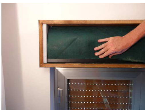
infilarlo nella barra di contenimento inferiore
