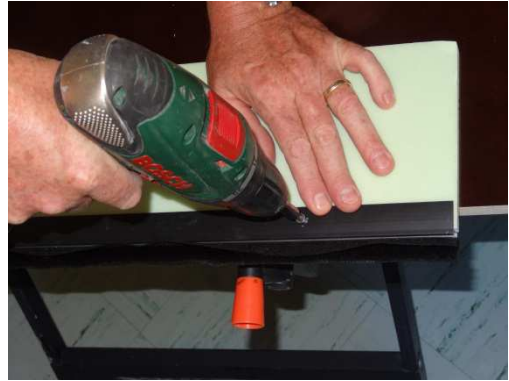
fissare il portaspazzolino sul bordo del pannello Termopav con le viti 4 x 16
