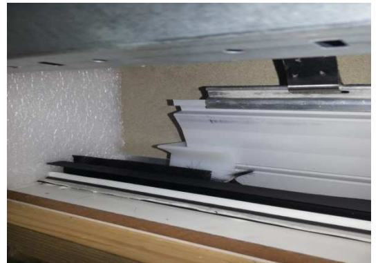
tagliare lo spazzolino in prossimità delle guide
