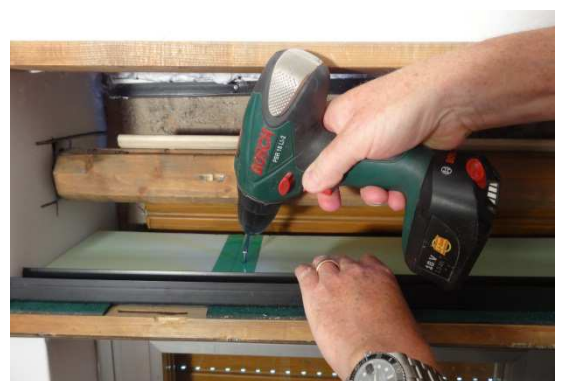
fissare il pannello con 2 o 3 viti da 4 x 30
