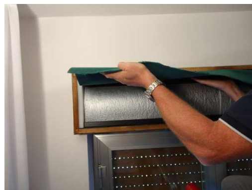
inserirlo nella parte superiore del cassonetto
