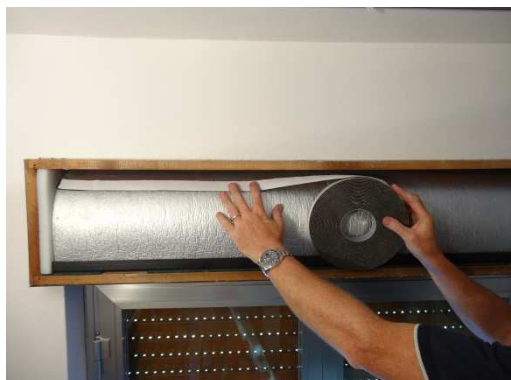
applicare il nastro biadesivo
