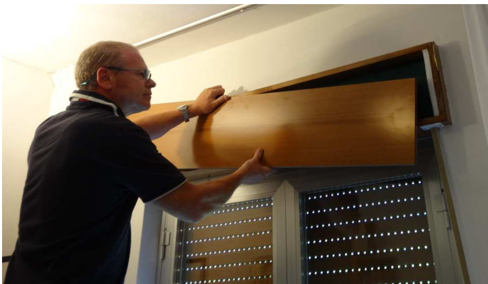
posizionare e fissare il celino di chiusura
