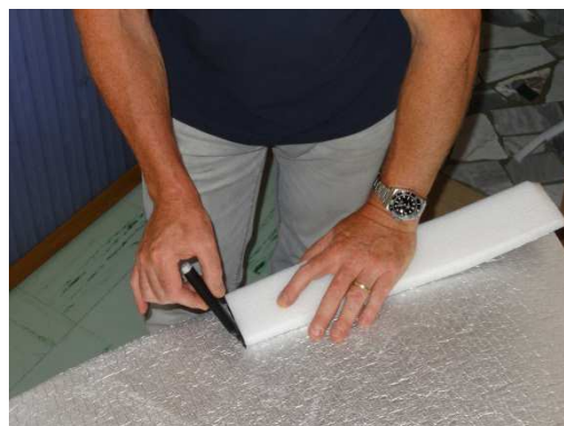
usare il campione per tagliare a misura
