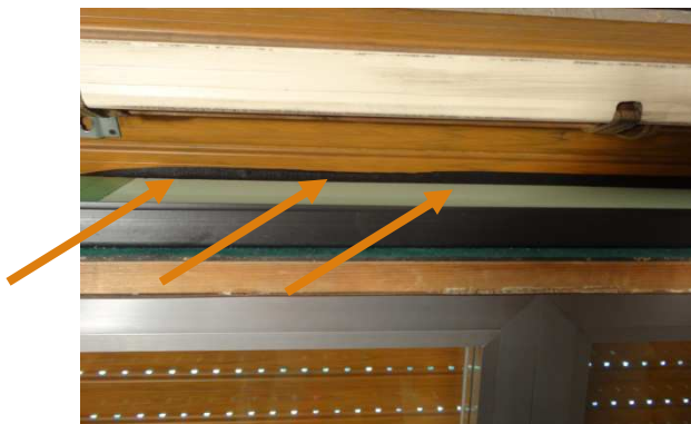
controllare che lo spazzolino sia sovrapposto al telo e chiuda bene
