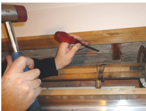
togliere le scabrosità che potrebbero ostacolare l'inserimento del pannello
