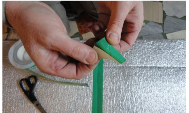
giuntarli con il nastro di tenuta
